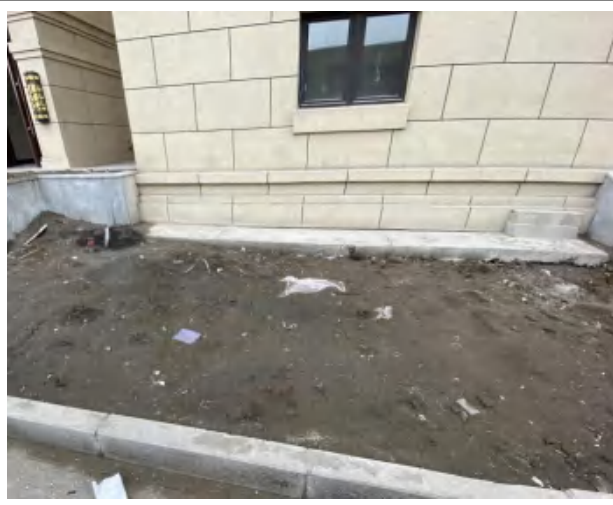
主体工程区表土回覆
