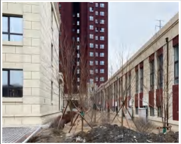
主体工程区景观绿化
