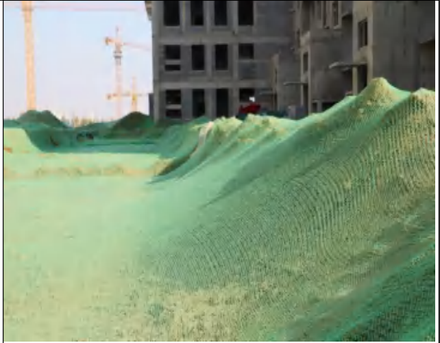
主体工程区苫盖
