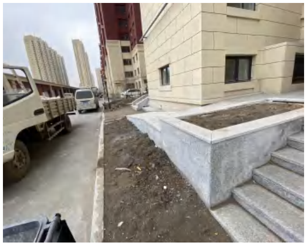
主体工程区表土回覆
