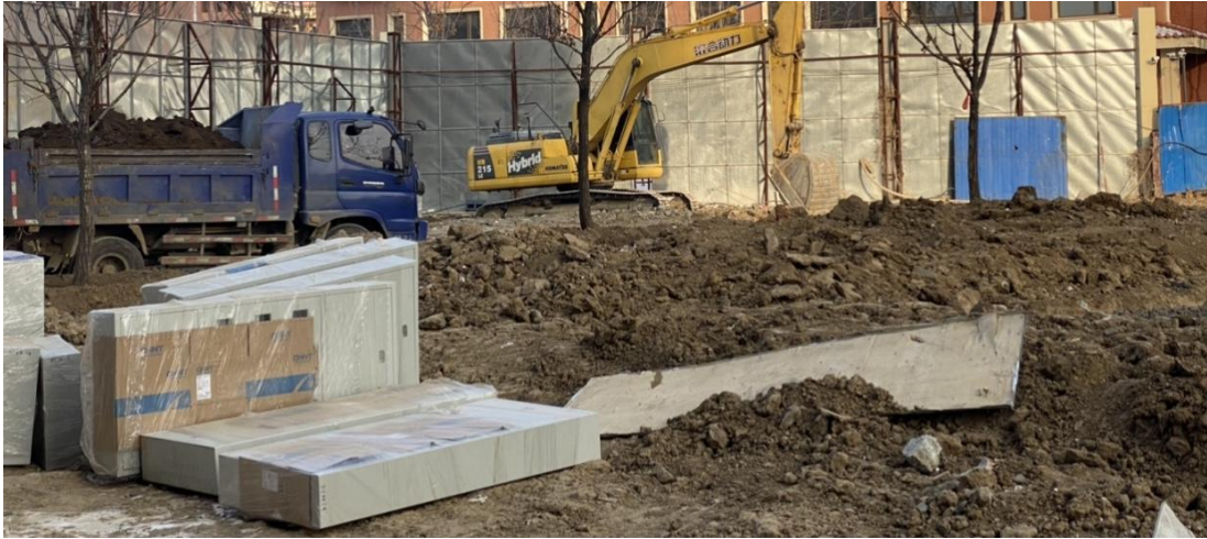
图 2-4 种植土回覆施工现场照片
