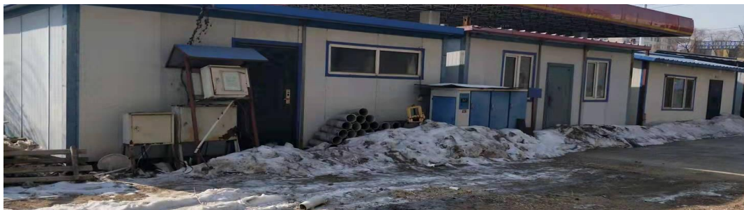
图 2-3 施工生产生活区现场照片
