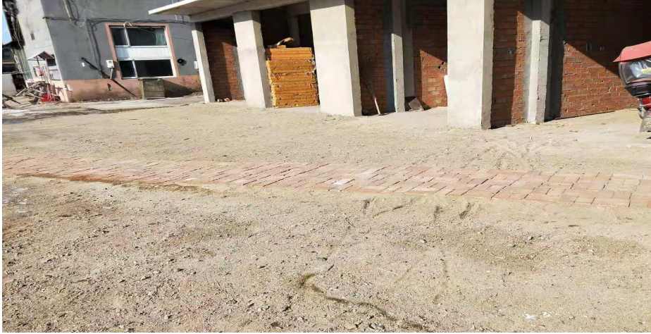
图 2-4 施工便道现场照片
