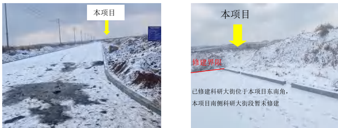
图 2.1-5 已建成科研大街东段现场照片
