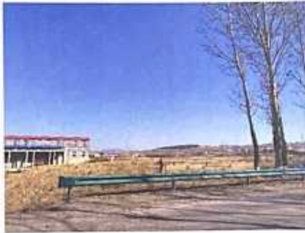
施工生产生活区
