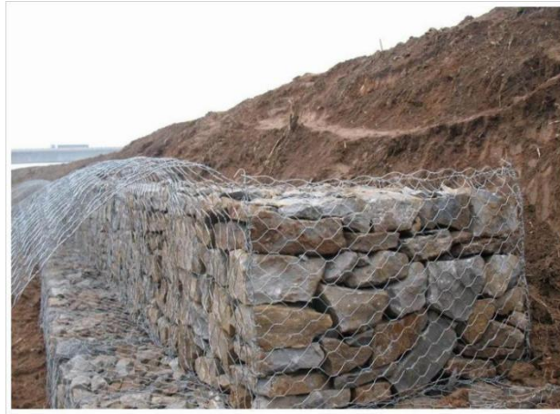
02 石笼挡墙措施
