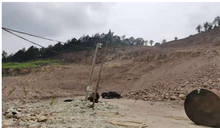
01 主体施工现状
