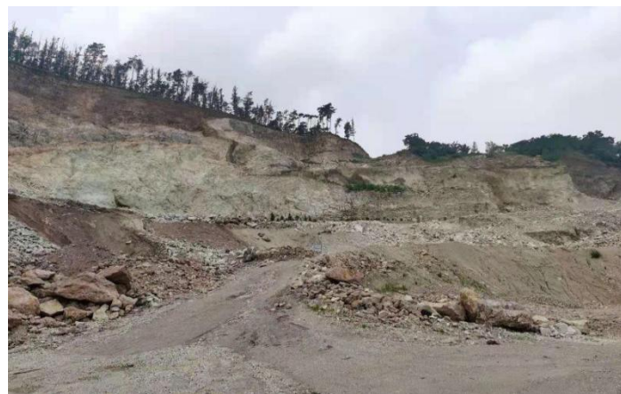
02 主体施工现状
