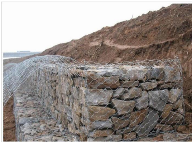
01 石笼挡墙措施
