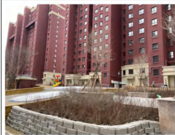
主体工程区景观绿化
