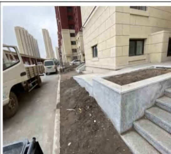
主体工程区表土回覆
