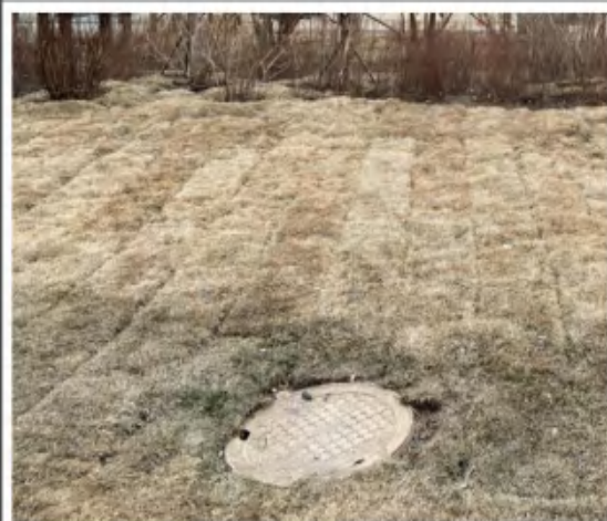
主体工程区排水口
