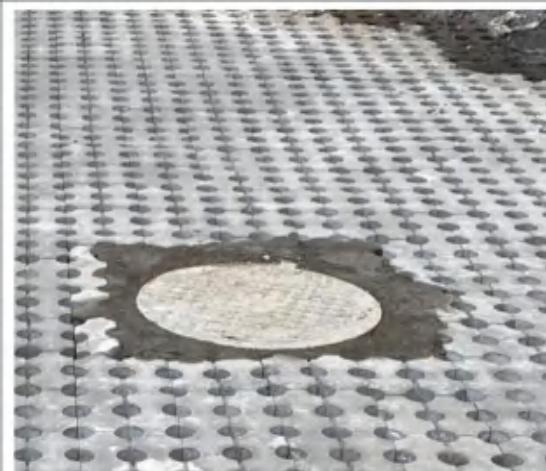
主体工程区排水口
