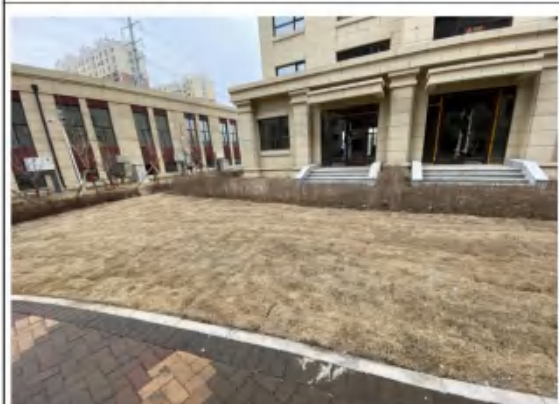
主体工程区景观绿化
