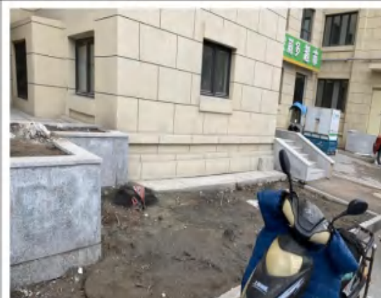
主体工程区全面整地
