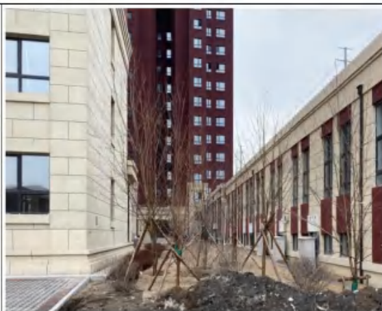
主体工程区景观绿化
