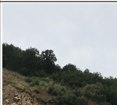
采场区生态护坡
