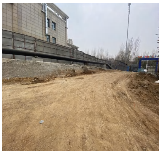
项目施工场地
