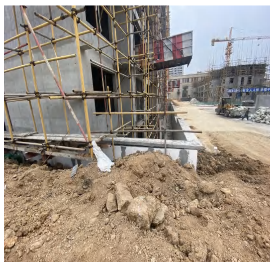
项目施工场地
