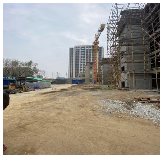
项目施工场地
