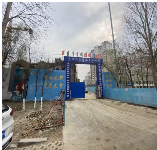
项目施工场地
