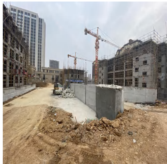
项目施工场地
