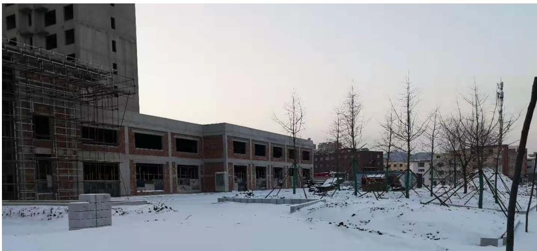
图 2-3 成品乔木的栽植现场照片
