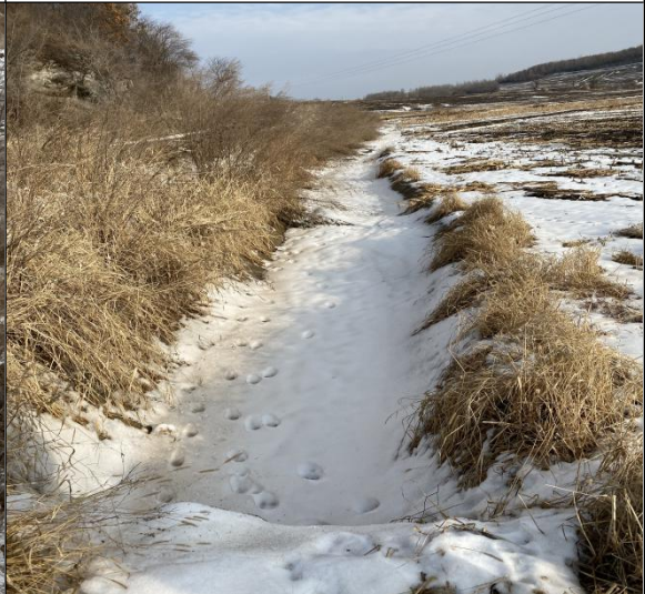
道路区排水沟
