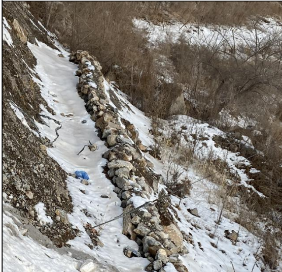
道路区排水沟
