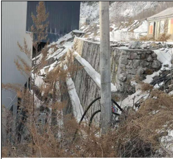
采场区浆砌石挡墙
