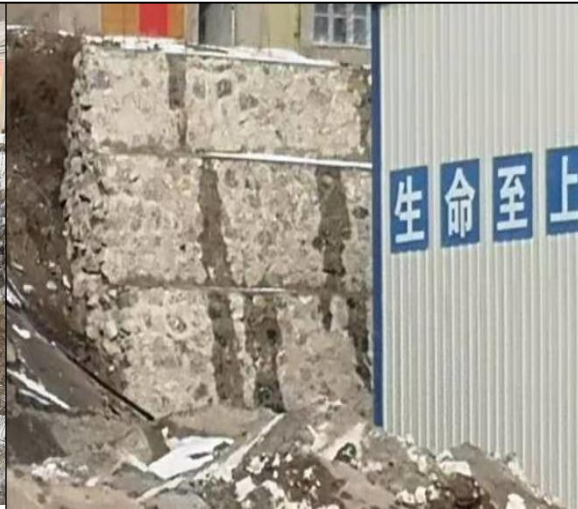
采场区浆砌石挡墙
