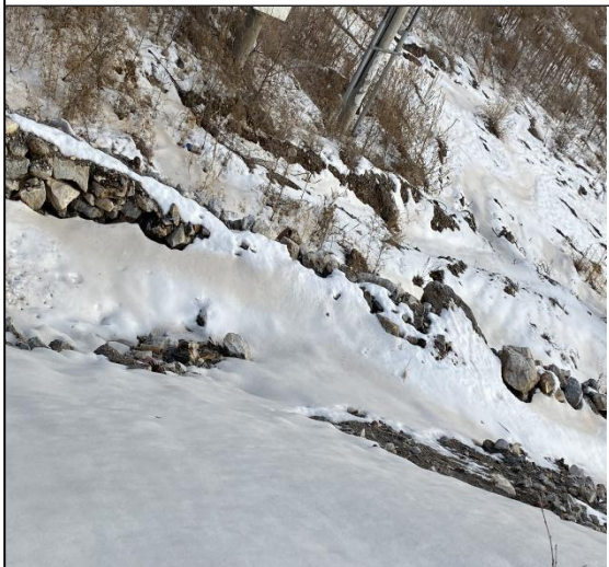
道路区排水沟
