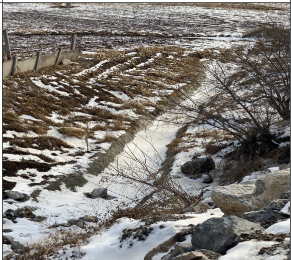
道路区排水沟
