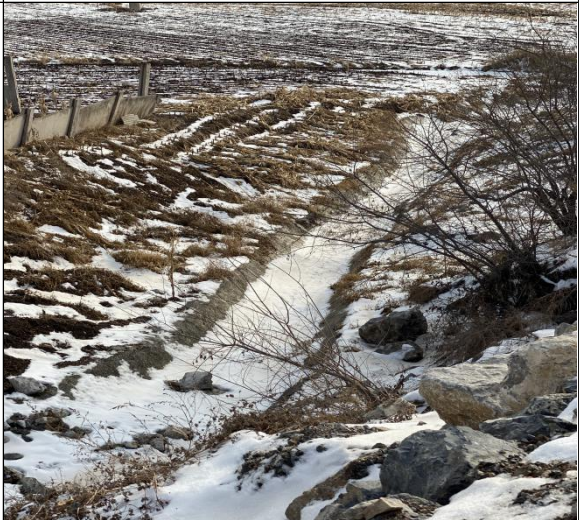
道路区排水沟
