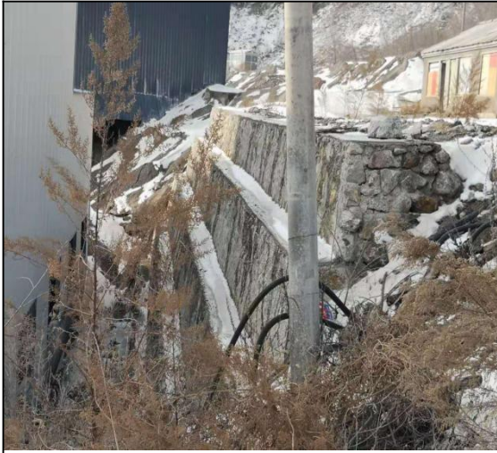
采场区浆砌石挡墙
