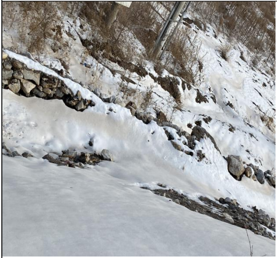
道路区排水沟
