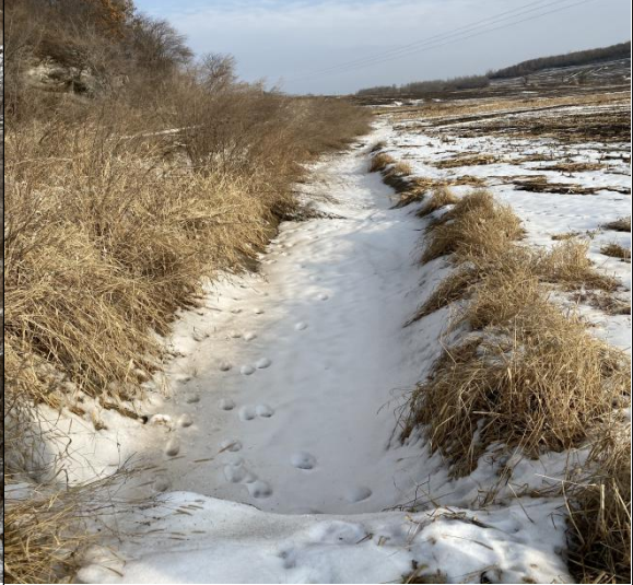
道路区排水沟
