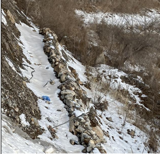
道路区排水沟
