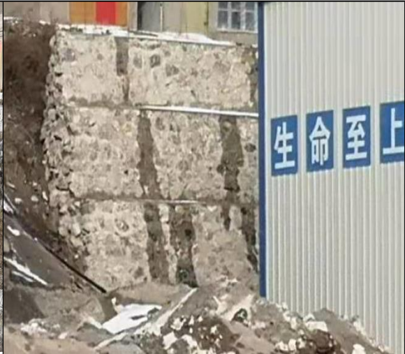
采场区浆砌石挡墙
